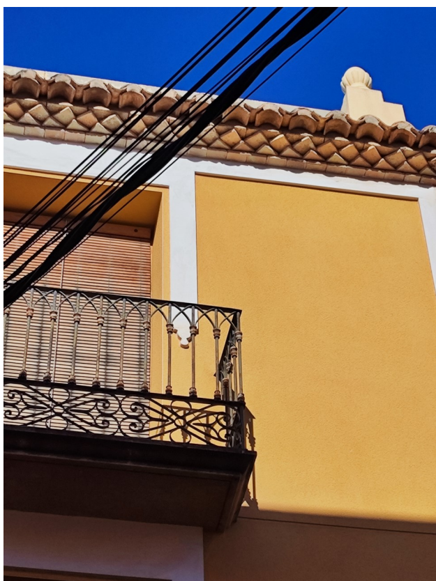
Img27. Detalle de rejería de forja y alero volado de esquinitas.
